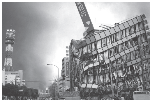
阪神・淡路大震災の被災状況
