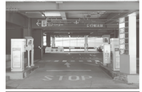
ゲート式駐車場管理システム
