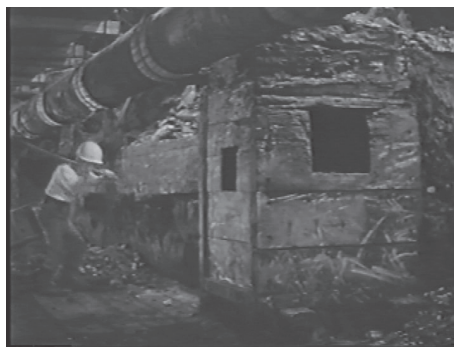
工事施工中の様子 (「八重洲地下街50年のあゆみ」より)
