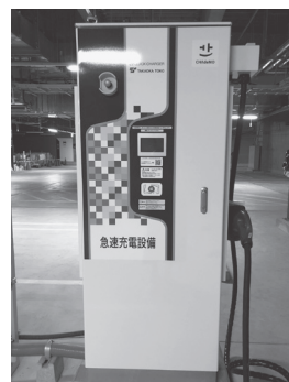
【EV充電器設置状況】
