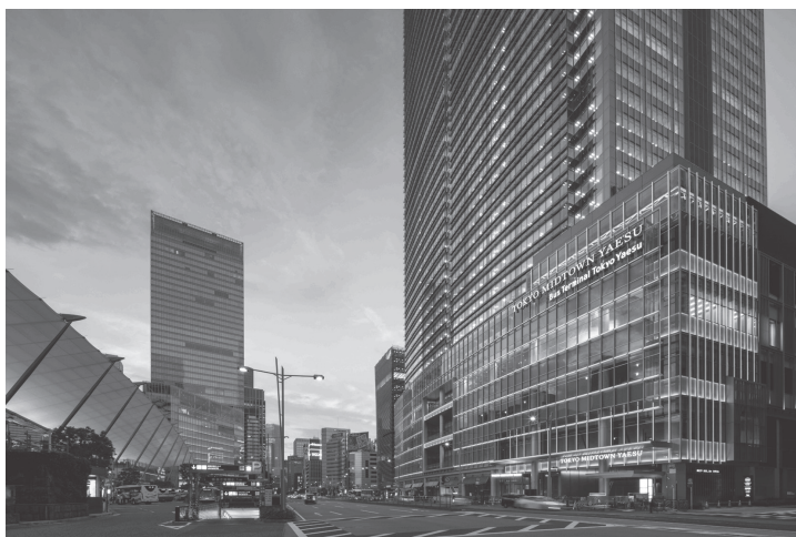
【東京ミッドタウン八重洲 外観】
