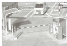
ゲート式駐車場管理システム
