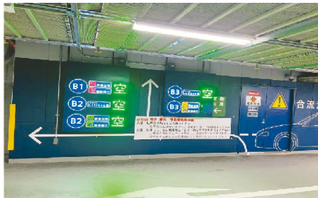
写真6：別フロアの満空表示をなくし該当フロアの情報のみに変更
