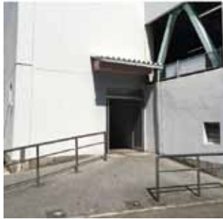
第一駐車場改修前
