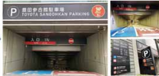
改修後(入口サイン、自立看板、路面カラー塗装)
