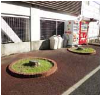
若宮駐車場外溝改修前
