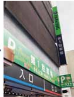
改修後(袖看板設置)
