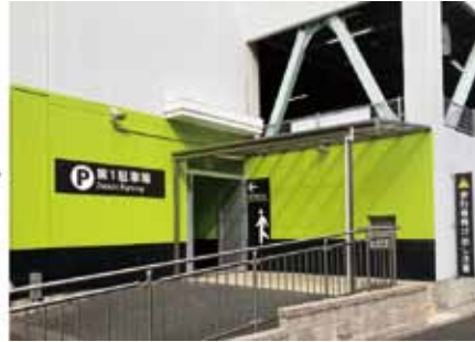
改修後(歩行者通路カラー塗装、屋根、手摺、スロープ・階段の整備)
