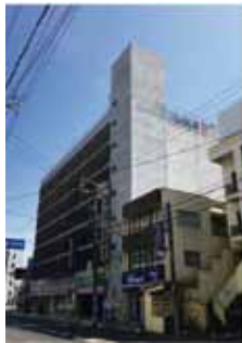
第1駐車場改修前
