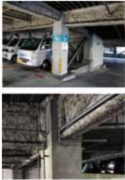
昭和町駐車場改修前
