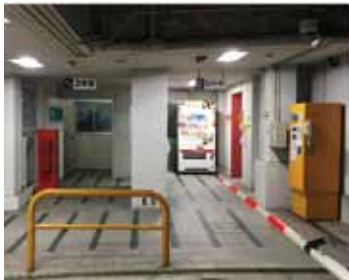
若宮駐車場改修前
