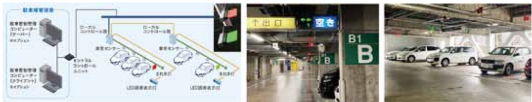
まねき灯のシステム構成、豊田参合館、第1駐車場におけるまねき灯設置状況
