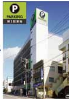
改修後(塔屋サイン設置)
