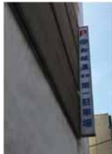
第1駐車場改修前
