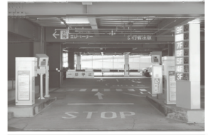
ゲート式駐車場管理システム
