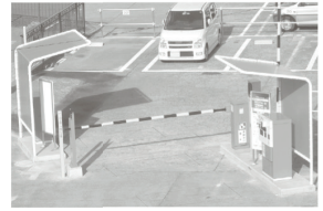
ゲート式駐車場管理システム
