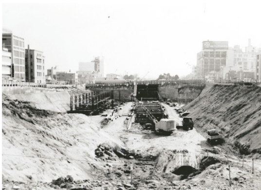
久屋地下駐車場と同時施工した栄・矢場町間の地下鉄工事 地上は久屋大通公園となる
