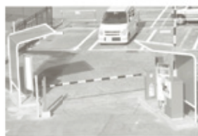
ゲート式駐車場管理システム
